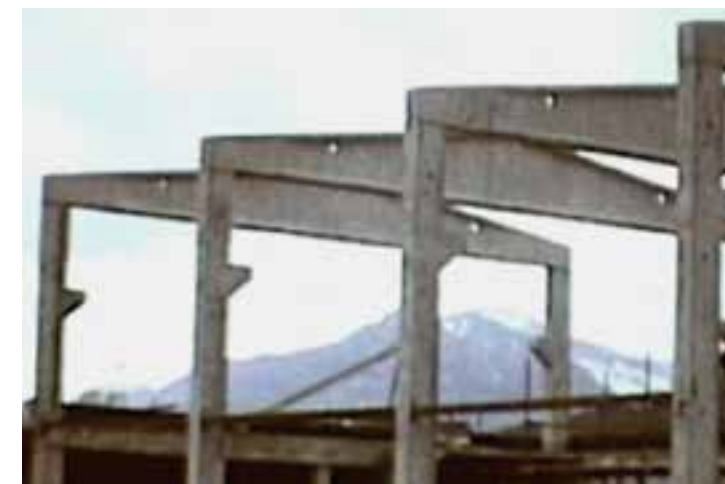
L'ossature de l'entrepôt à rayonnages en hauteur est prête.
