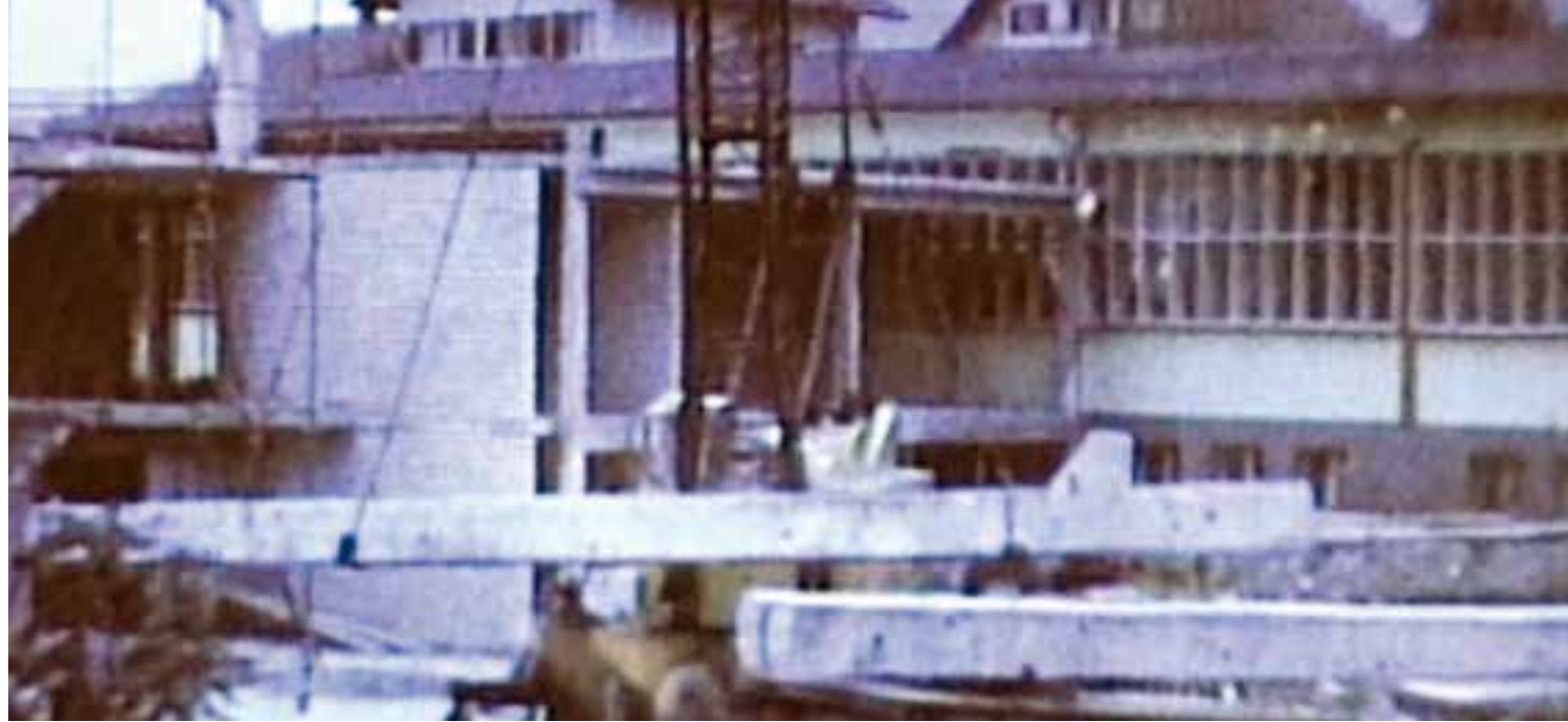
Les éléments préfabriqués en béton pour l'entrepôt à rayonnages en hauteur sont livrés et posés. (image fixe d'un film documentaire datant de 1967)
